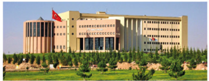
Erciyes Üniversitesi Rektörlük Binası / KAYSERİ Kapasite: 800 kg
