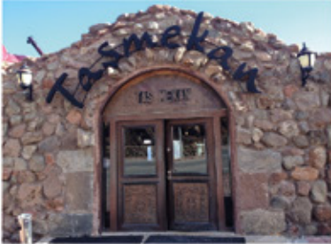
Taş Mekan Et Lokantası / KAYSERİ 2 Asansör, Kapasite: 800 kg
