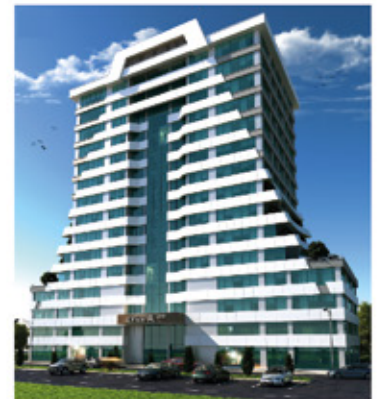
Office A Plus İş Merkezi / KAYSERİ 2 Asansör, Kapasite: 1000 kg / 2,5 m/sn.
